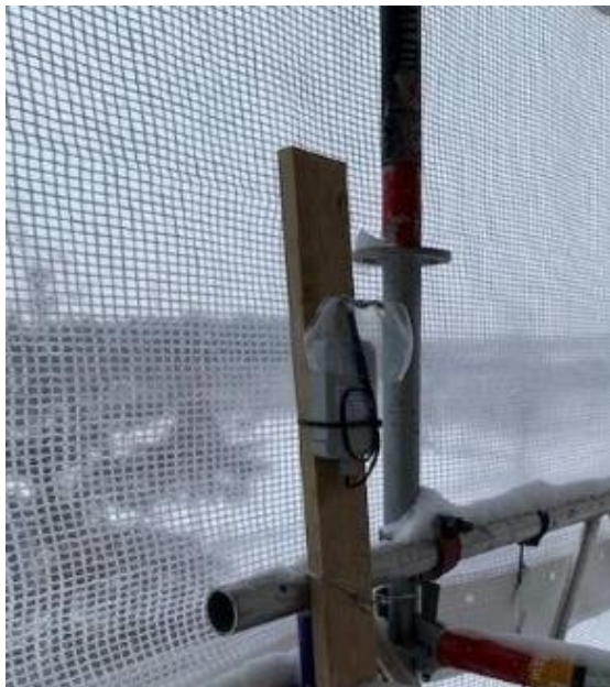
Figur 5. Montage av givare (exempel).
